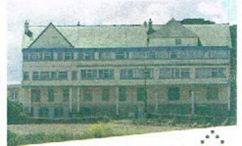
Bâtiment à réhabiliter
